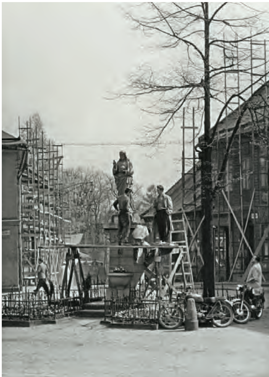
← Około 1960. Remont figury Chrystusa na placu Inwalidów Wojennych (obecnie Górnym Rynku) w ramach przygotowań do obchodów 1150-lecia miasta
