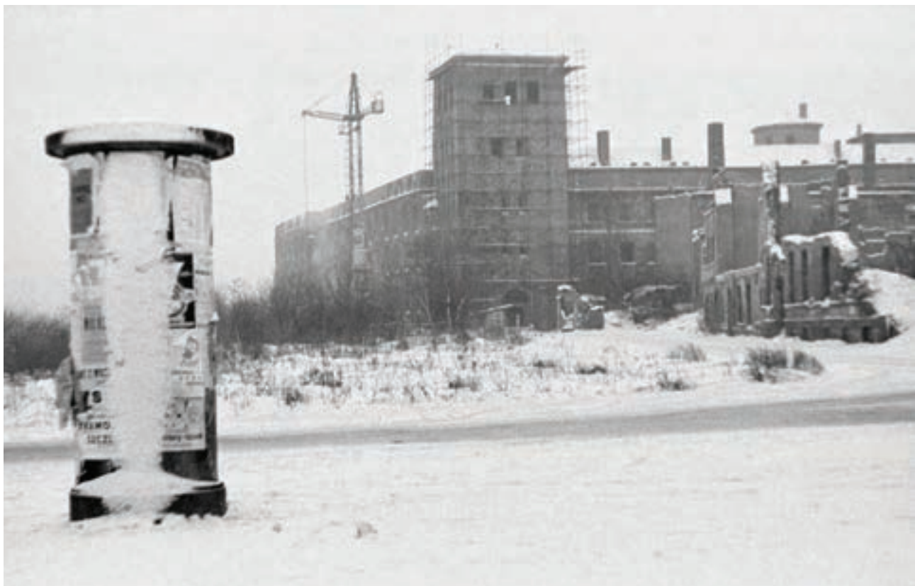
↑ 1947. Odbudowa Zamku Książąt Pomorskich FOT. BOGDAN CELICHOWSKI / FORTEPAN
