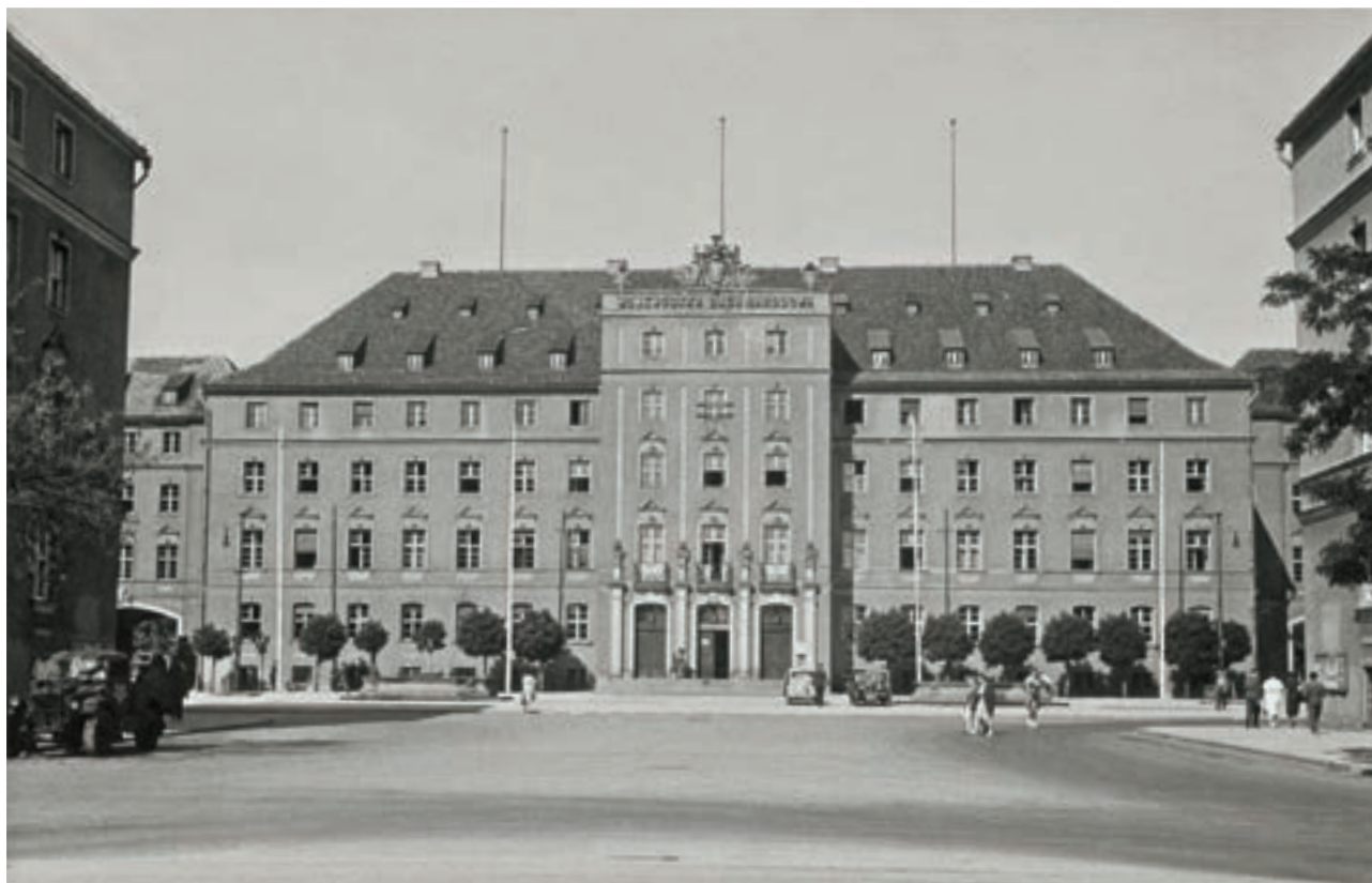
↑ 1948. Gmach Zarządu Miejskiego na placu Niezłomnych FOT. K. KOMOROWSKI / INSTYTUT ZACHODNI
